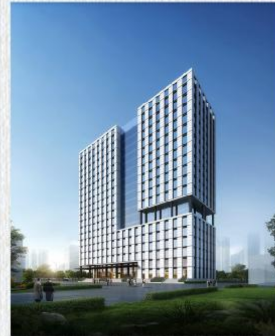
人工智能大厦（在建中）
